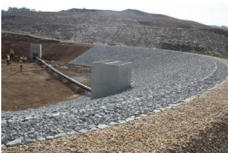
Снимка 5-01: Строително - монтажни работи по проект „Закриване и рекултивация на общинското депо за неопасни отпадъци в землището на гр.Созопол, Община Созопол“
